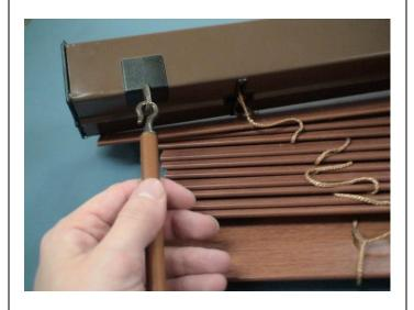
16. Réinstallez le store dans les supports de montage. Réinstallez la cantonnière dans les attaches de montage.
