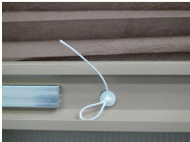
6. Remplacer la lamelle en aluminium et capuchon d'extrémité en faisant attention de ne pas cabosser la lamelle. Suggestion: Placer un morceau de ruban adhésive sur le bout de la lamelle en aluminium pour le rendre plus facile à glisser.
