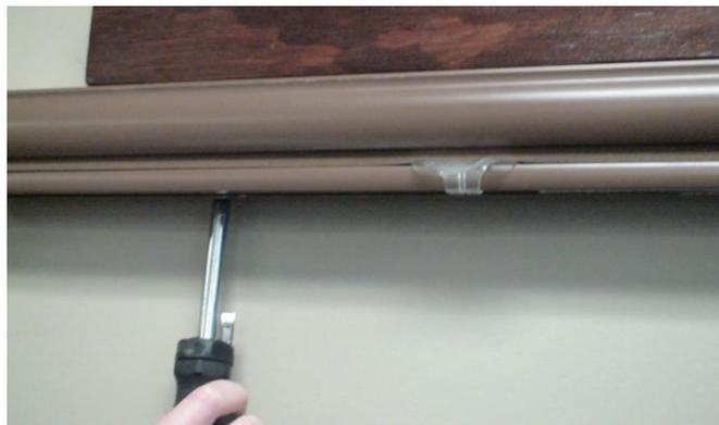
2. Soulevez et abaissez le store pour voir si il fonctionne lorsque pas dans les supports. Si le store soulève et abaisse correctement, déplacez les supports d'extrémité afin qu'ils soient d'un minimum de 3 po de chaque extrémité du rail de retenue.
