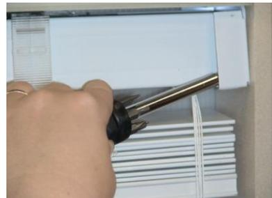
3. Enlevez les glands et les rondelles des cordes d'inclinaison et les mettre de côté. Si le store a plus de 2 cordes, le gland d'arrêt droit être enlever et le nœud déliée.
