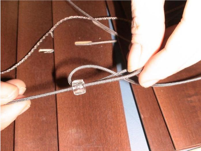
**22.** Pousser la perle d'arrêt et le nœud de relâchement vers les supports jusqu'à ce que la perle d'arrêt de cordon est 1 à 2 po en-dessous les supports.
