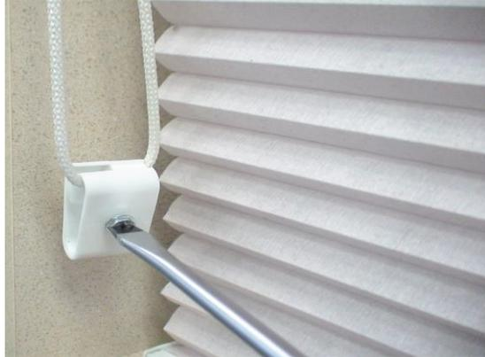
2. Enlevez le store des supports en utilisant un tournevis plat. Insérez le bout du tournevis entre l'arrière du support et le rail de retenue.
