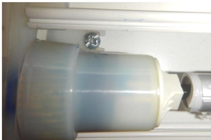
13. Réinsérer le diviseur de cordon sur le mécanisme. Il faut vous assurer que la corde est bien installée dans les rainures du diviseur de cordon. Faire glisser le diviseur vers le haut et dans le mécanisme.
